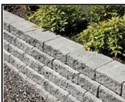
**Muret en blocs de béton préfabriqués**
